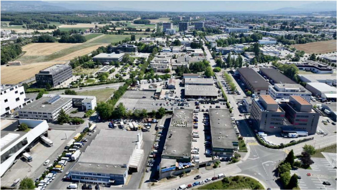
Luftaufnahme des Industriegebiets Meyrin-Satigny-Vernier (ZIMEYSAVER) | 2022: Tausende Quadratmeter dunkler Flachdächer, der vollen Sonne ausgesetzt, die Wärme absorbieren, statt sie zu reflektieren. ©FTI – Olivier Riethauser
