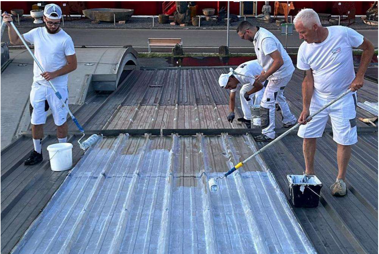
Ein transluzenter Lack auf den Trägern: Er reflektiert die Sonnenenergie und lässt zugleich das sichtbare Licht durch. Eine gleichmäßige und kontrollierte Beschattung, dort, wo die Kreide ungenau und schmutzend blieb.
